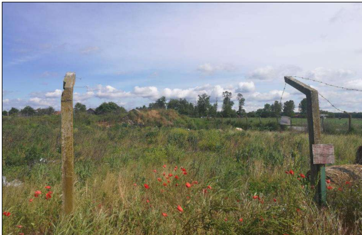
Slika 2.1.-2. Pogled na derutnu ogradu s južne strane s vidljivim odloženim otpadom te ulazom na prostor odlagališta
